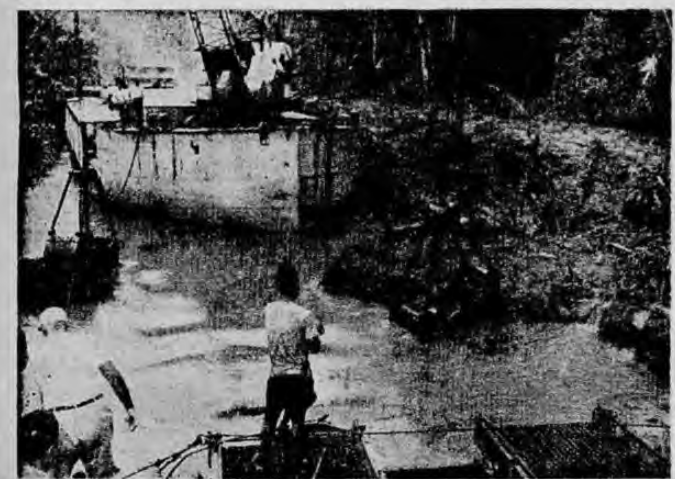
30 KILOMETROS DE CANALES. —Quedan habilitados con la apertura del tramo de estas obras que ayer fue concluido por el Ministerio de Transportes en los lagunas del Atlántico. En la gráfica los dos dragos que el M. T., tiene trabajando en este vasto proyecto, cuando socaban las últimas cantidades de cieno para dejar que las aguas se enlacen.
